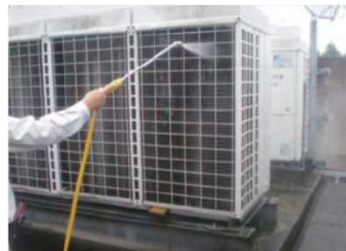
室外機(外)の洗浄状況
